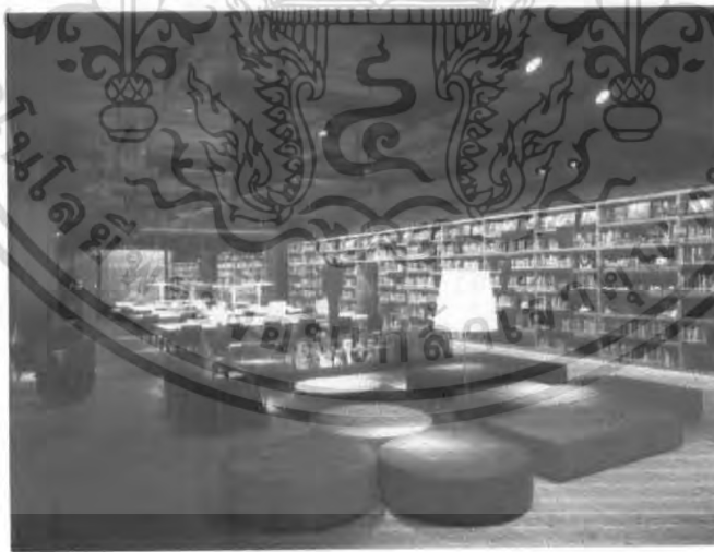
ภาพที่ 3.24 แสดงการให้แสงสว่างในระบบโคมไฟฟ้ายาวตั้งฉากกับแนวชั้นวางหนังสือ
