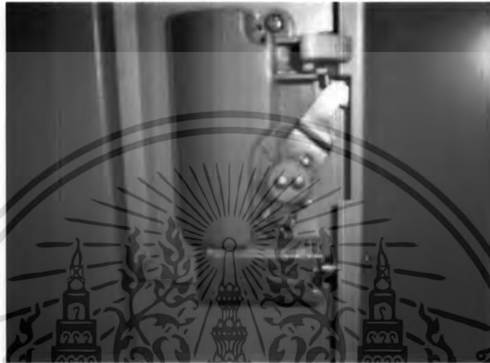
รูปที่ 3.3 การติดตั้งโซลินอยด์
