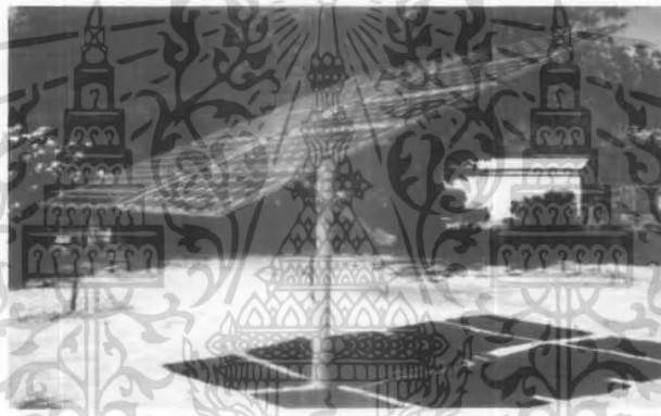
รูปที่ 3.2 ตัวอย่างแผงเซลล์ที่ใช้ระบบติดตามดวงอาทิตย์แบบแกนเดียว
