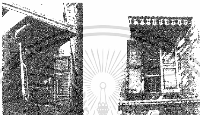
ภาพที่ 24 แสดงภาพค้ำยันกันสาดและกันสาดคอนกรีต
