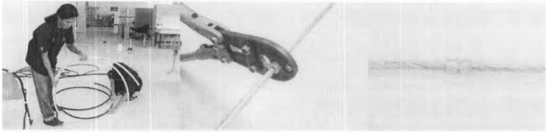
รูปที่ 3.11 การประกอบ Equalizer กับสายตัวนำ
