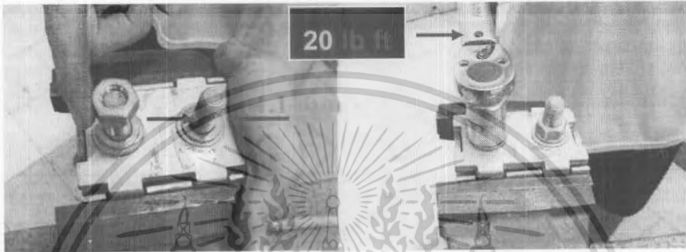
รูปที่ 3.18 การวัดขนาดเส้นผ่าศูนย์กลางเพื่อเลือกค่าแรงบิดตามมาตรฐาน ANSI C119.4 - 2004
