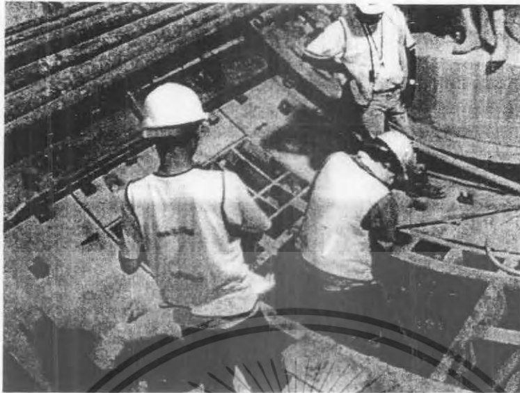
รูปที่ 5.8. การติดตั้งชิ้นส่วนผนังอุโมงค์
