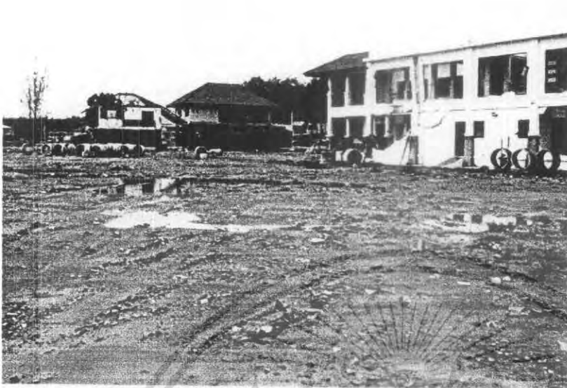
มองจากทางทิศใต้เข้าสู่ตัวอาคาร
