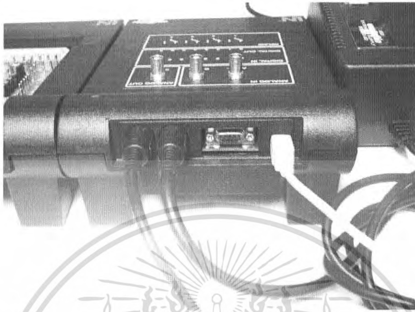
รูปที่ ก.3 การต่อสาย USB และการต่อสายแหล่งจ่ายให้กับชุดควบคุม
