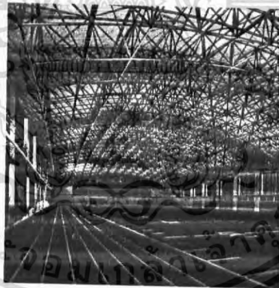
ภาพ4-16 แสดงสนามกีฬาที่ใช้โครงสร้าง SPACE TRUSS
