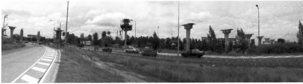
ภาพ3-16 แสดงส่วนต่อขยายรถไฟฟ้าBTS เส้นสีเขียวที่มาจากสถานตากสิน
