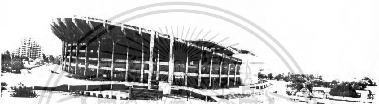
ภาพ4-19 โครงสร้าง RIGID FRAME กับงานสนามกีฬาราชวังมงคลกีฬาสถาน
