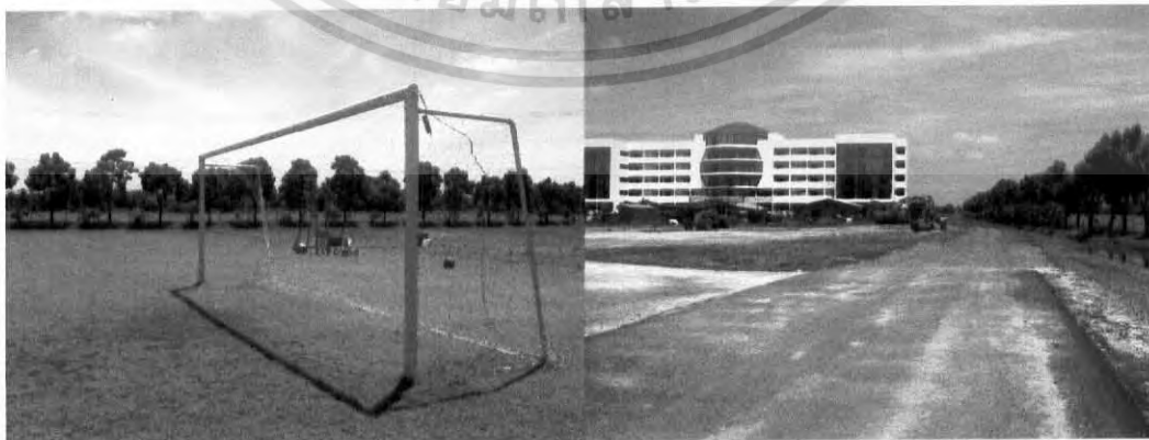
ภาพ3-9 แสดง ภายในโครงการ ที่มีการก่อสร้างไปบางส่วน
