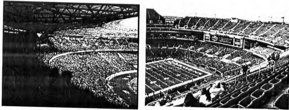
ภาพ 4-13 รูปเปรียบเทียบอัฒจันทร์ชั้นเดียวกับหลายชั้นในด้านพื้นที่ใช้สอยและความประหยัด
