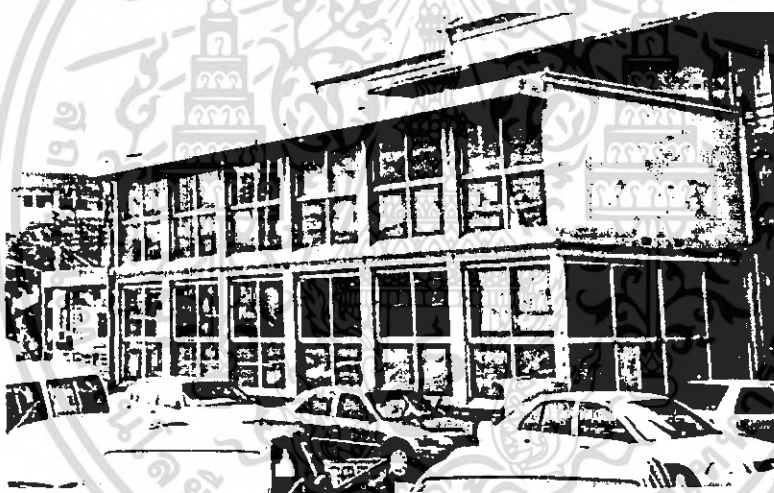
ภาพประกอบที่ 2.6-6 แสดงรูปภาพตู้คอนเทนเนอร์ดัดแปลงแบบถอดประกอบได้ ( สำนักงานของโรงพยาบาล วชิระ )
