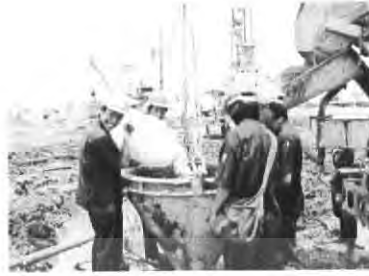
รูปที่ 3.37. แสดงเม็ดโฟมที่ใส่ลงไปในหลุมเจาะ
