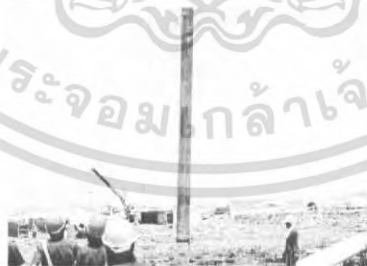
รูปที่ 3.33. แสดงท่อเทคอนกรีต
