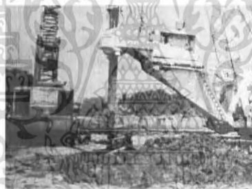
รูปที่ 3.29. แสดงหัวเจาะแบบสว่าน
