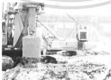
รูปที่ 3.30. แสดงหัวเจาะแบบถัง
