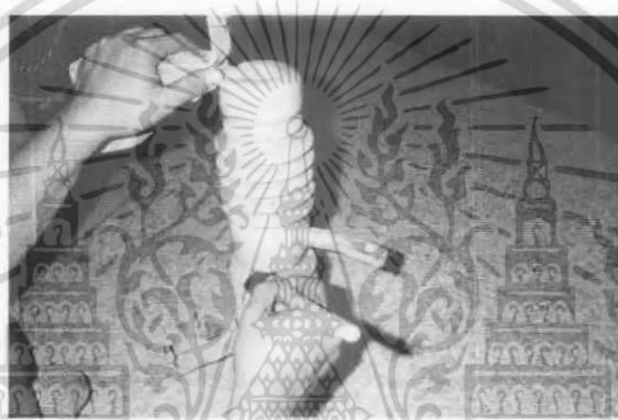
(ค) การเก็บสิ่งเปราะเปื้อนที่เกาะอยู่บนผิวของดรอปเอ้าท์พิวส์
