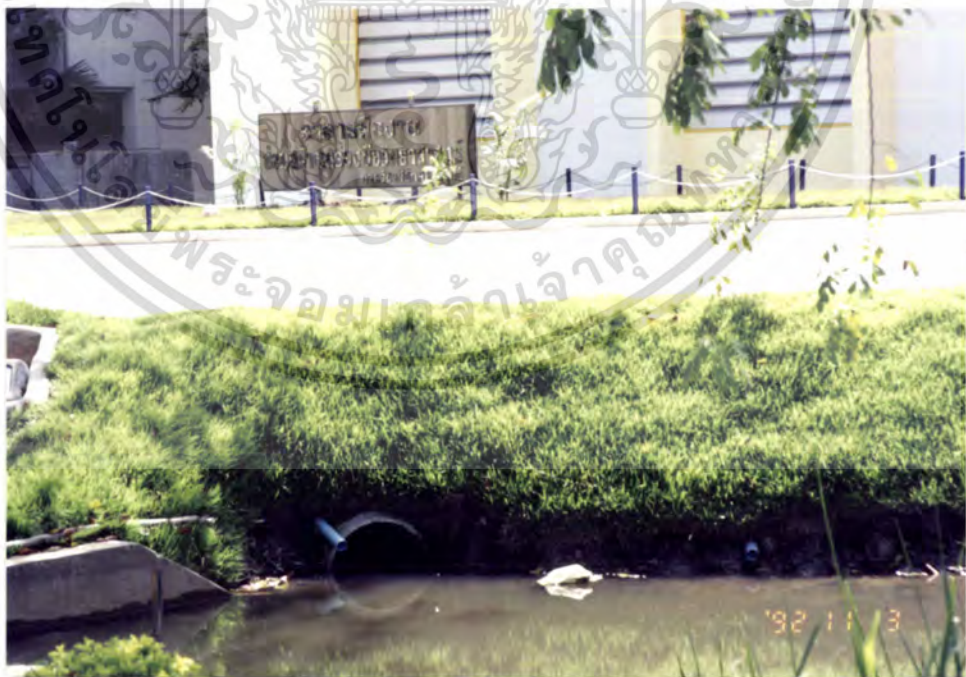
รูปที่ 31 ลักษณะการระบายน้ำที่ออกมาตามคูน้ำ บริเวณหน้าคณะวิทยาศาสตร์
