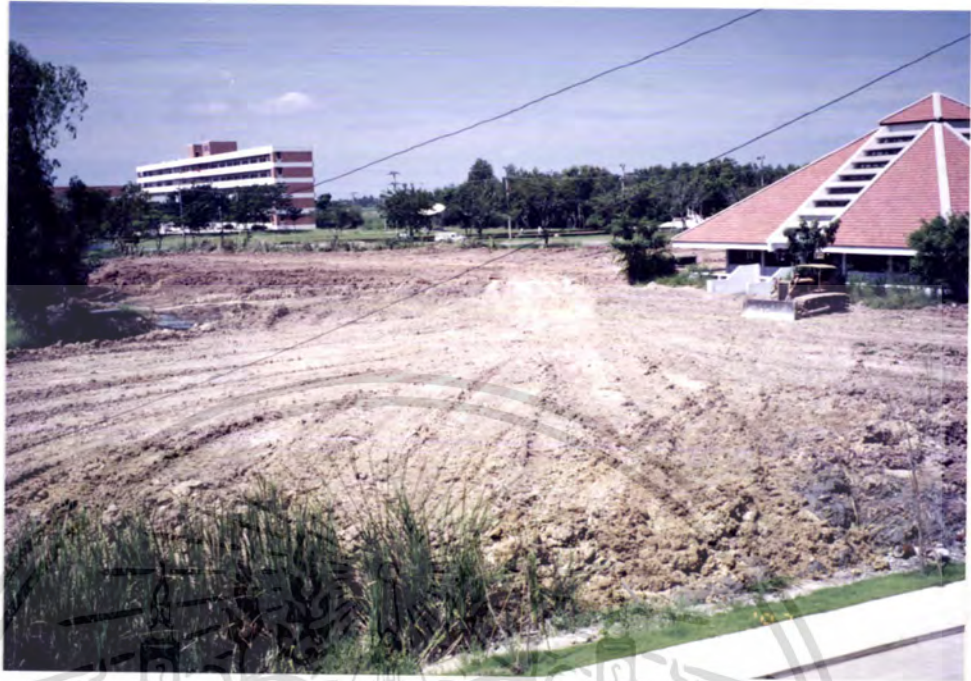
รูปที่ 12 รูปแสดงพื้นที่ถมการถมเพื่อก่อสร้างอาคารใหม่
