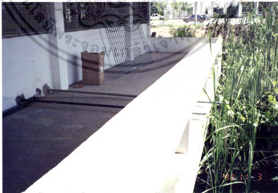
รูปที่ 36 การระบายน้ำทิ้งสารเคมี ของอาคารฝึกงานเคมีและเทคโนโลยีโพลีเมอร์ เอกสารนี้เป็นเอกสารที่สงวนไว้สำหรับการใช้งานเพื่อการศึกษาดูงานเท่านั้น ไม่อนุญาตให้ทำซ้ำโดยไม่ได้รับอนุญาต ไม่ว่ากรณีใดๆ ทั้งสิ้น อีกทั้งห้ามมิให้คัดแปลงเนื้อหา และต้องอ้างอิงถึงเจ้าของเอกสารทุกครั้งที่มีการนำไปใช้
