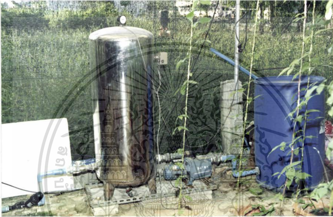
ภาพที่ 8 การติดตั้งชุดเครื่องกรองน้ำ
