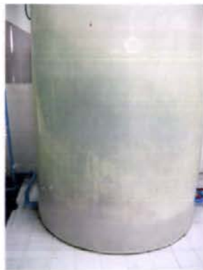
ภาพที่ 58 ถังเก็บน้ำดิบที่ภายในมีตะไคร่น้ำเกิดขึ้น
