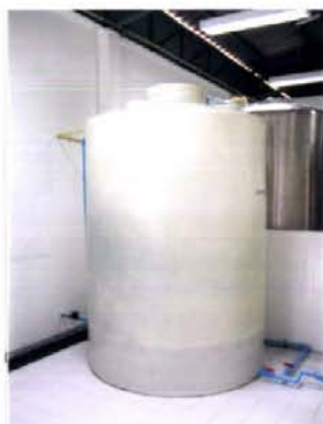
ภาพที่ 58 ถังเก็บน้ำดิบที่ภายในมีตะไคร่น้ำเกิดขึ้น
