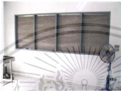
ภาพที่ 32 ห้องบรรจุที่ได้มีการเปลี่ยนหน้าต่างบานเกร็ดเป็นแผ่นฝ้ายิปซัม
