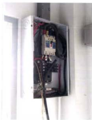
ภาพที่ 61 ตู้ควบคุมกระแสไฟฟ้าที่ไม่ได้ปิดฝาครอบ
