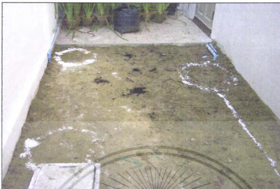
ภาพที่ 7 แสดงการโรยปูนขาวเพื่อกำหนดตำแหน่งเตรียมหลุมปลูกต้นไม้
