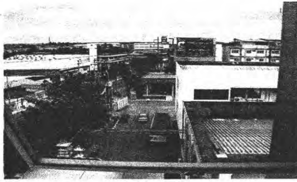
ภาพที่ 3.6 แสดงทัศนียภาพบริเวณข้างเคียงทางทิศใต้ พื้นที่ด้านข้างติดต่อกับแนวเขตถนนและโรงงานอุตสาหกรรม ของบริษัทไทย
