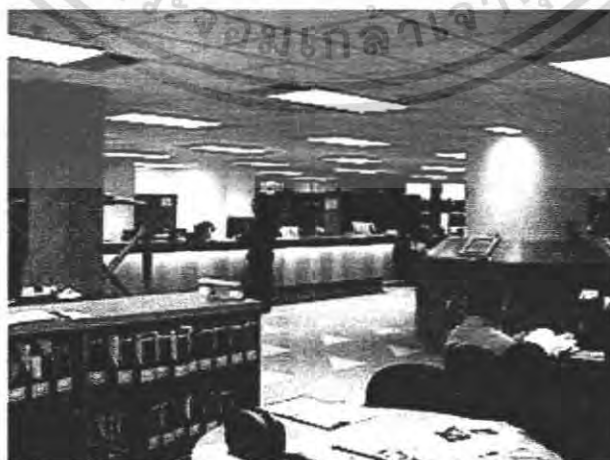
ภาพที่ 2.51 ลักษณะของการจัดวางดวงโคมแบบสมมาตรในสำนักงานทั่วไป
