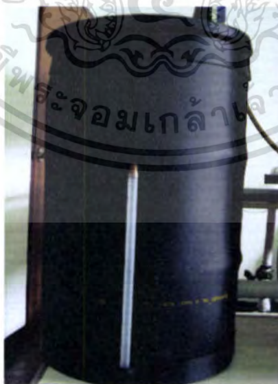
รูปที่ 3.6 ถังเติมสารทำความเย็น
