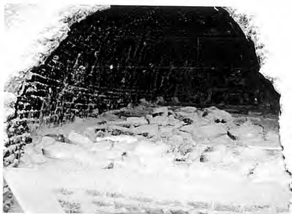
ภาพที่ 9 เตาก่อที่ใช้เผาผลิตภัณฑ์เครื่องปั้นดินเผา ที่มา: (กลุ่มหัตถกรรมเครื่องปั้นดินเผาเกาะเกร็ด หมู่ 1)
