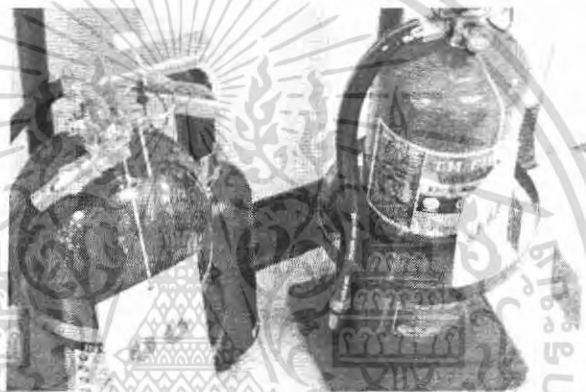
ภาพที่ 6.2.8.3 แสดงเครื่องดับเพลิงแบบมือถือที่สามารถดับเพลิงได้ทุกประเภทของเพลิงไหม้
