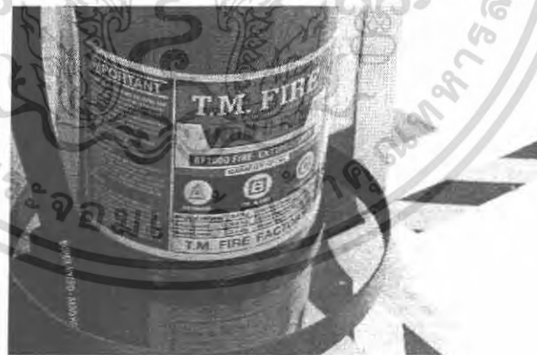
รูปที่ 6.2.8.4 แสดงเครื่องดับเพลิงแบบมือถือที่สามารถดับเพลิงประเภท ก , ข , ค
