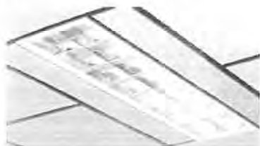
ภาพที่ 2.46 แสดงลักษณะ โคมฟลูออเรสเซนต์ตะแกรงแบบพาราโกลิเจอร์ส
