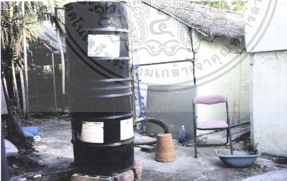
ภาพที่ 6 เครื่องกำเนิดไอน้ำ
