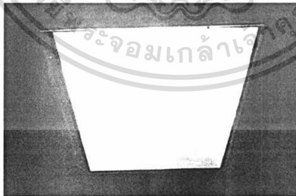
ภาพที่ 3ผ ลักษณะของหลอดไฟที่มีฝาพลาสติกครอบภายในอาคารผลิต
