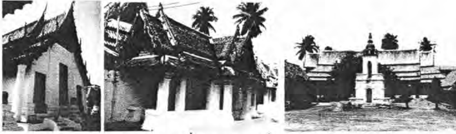
ภาพที่ 4.9 อาคารเครื่องก่อ
