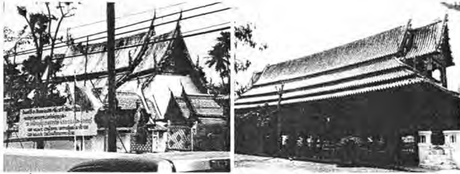
ภาพที่ 4.97 การแตกปริมาตรหลังคาอุโบสถ และการสร้างเส้นโค้งหงายตัววัดรับกับข้อฟ้า เพื่อ สร้างสรรค์ความเบา
