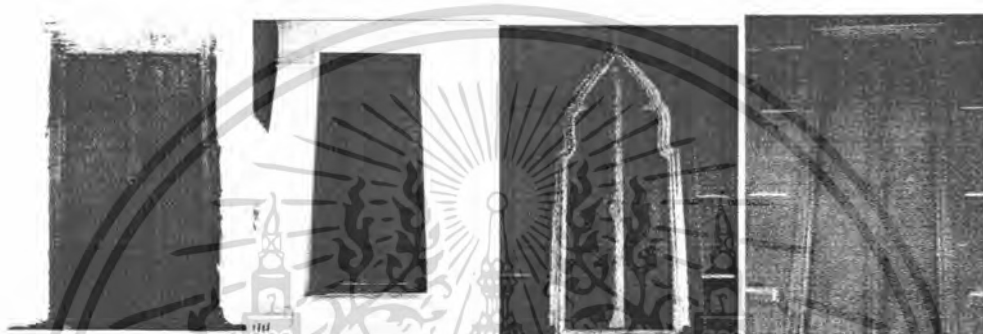
ภาพที่ 4.27 ลักษณะบานประตู แบบกลอนดาลธรรมดา
