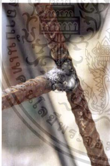
รูปที่ 37 เชื่อมเหล็ก 2 เส้นติดกัน
