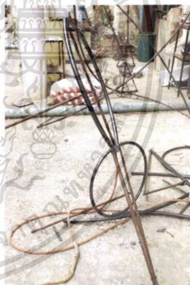
รูปที่ 38 โครงสร้างเหล็ก
