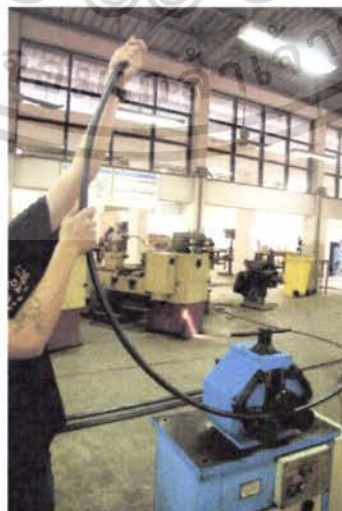
รูปที่ 34 ท่อเหล็กถูกงอให้โค้งเท่ากันโดยตลอด
