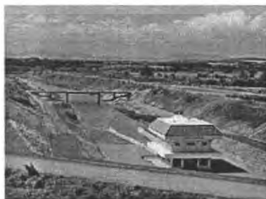
รูปที่ 3.9 อาคารระบายน้ำลงลำน้ำเดิม
