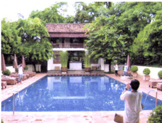
รูปภาพ2.6 อาคารบริเวณสระว่ายน้ำ
