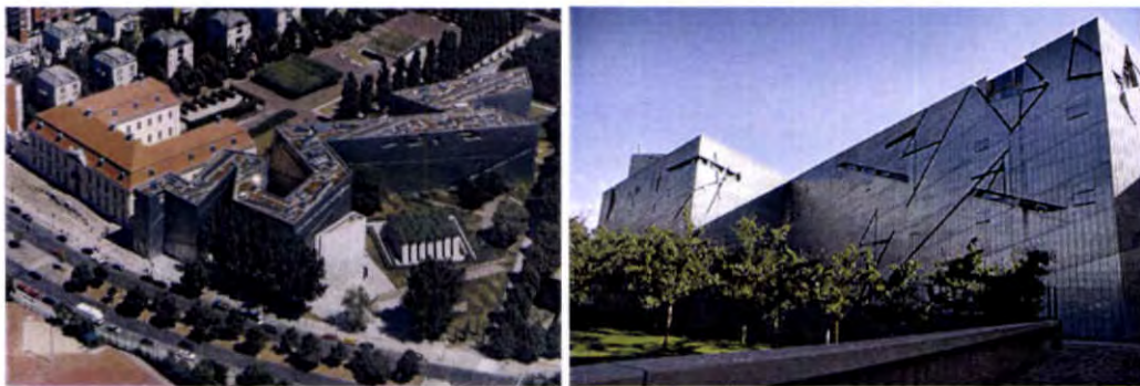
รูปที่ 3.7 แสดงลักษณะภายนอกของอาคาร
