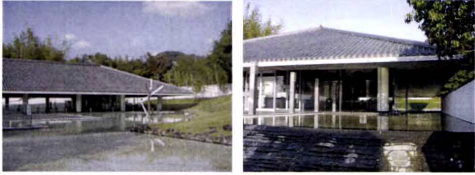
รูปที่ 3.21 แสดงลักษณะภายนอกอาคาร
