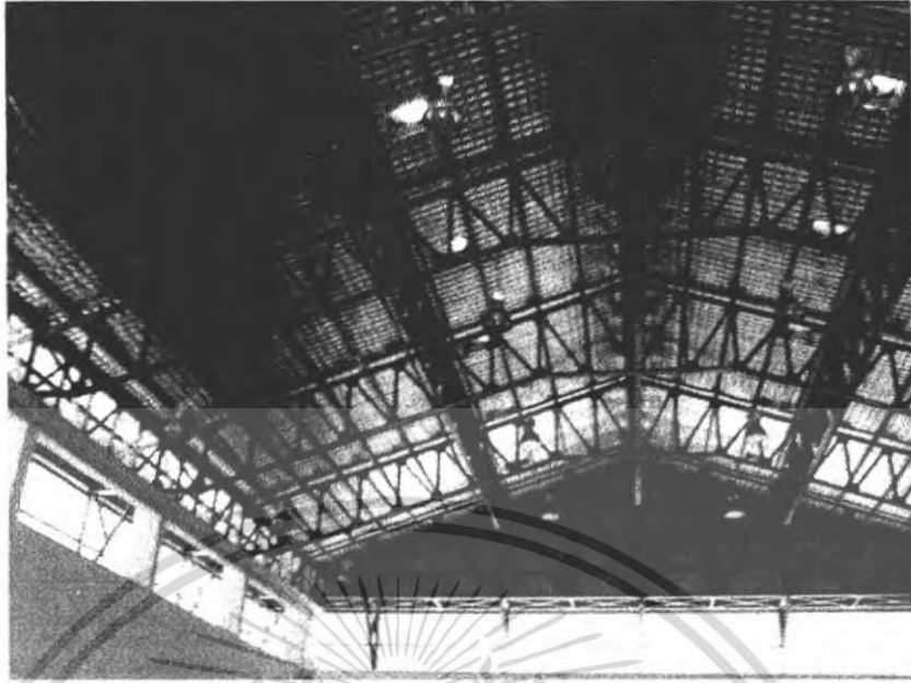
รูปที่ 2.38 โครงสร้างหลังคาของอาคารที่ 3
