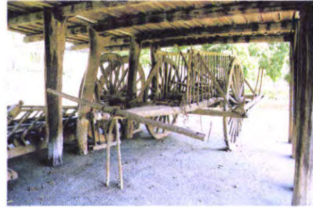
ภาพที่ 19 ได้ถุนบ้าน แสดงให้ เห็นเสาซึ่งเป็นไม้ง่าม
