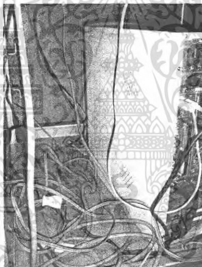
รูปที่ 1.2 ตัวอย่างของปัญหาเรื่องการจัดเก็บสายไฟ
