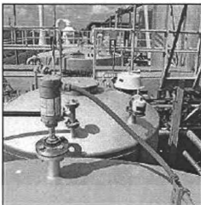
ภาพที่ 3.22 แสดงการติดตั้ง Level Transmitter ที่ถัง
