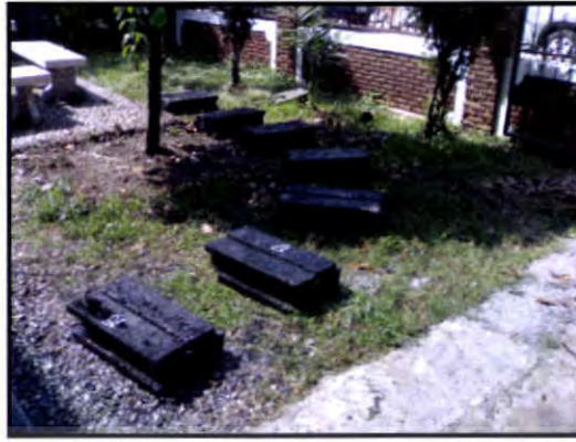
รูปที่ 4.16 การประยุกต์ใช้ก้อนแอสฟัลต์ใช้ทำทางเดินภายในสวน
