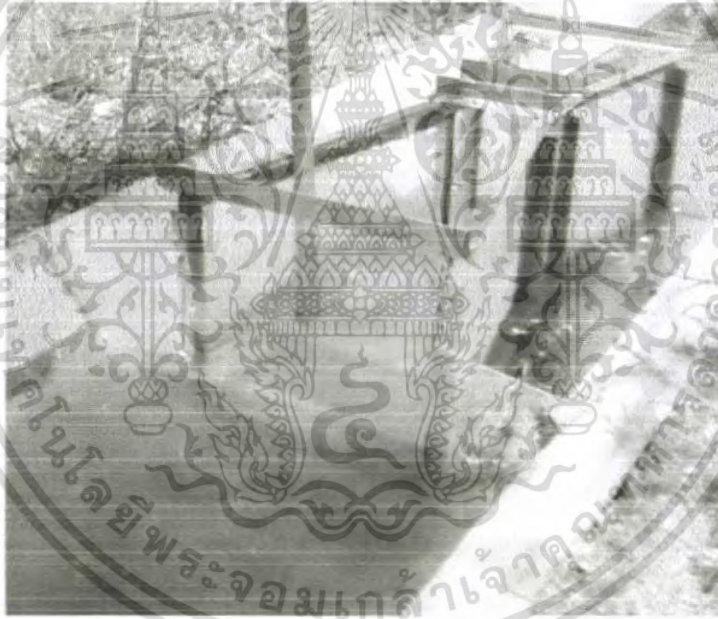
รูปที่ 2.7 การติดตั้งรางวัดน้ำแบบพาร์เซลล์
