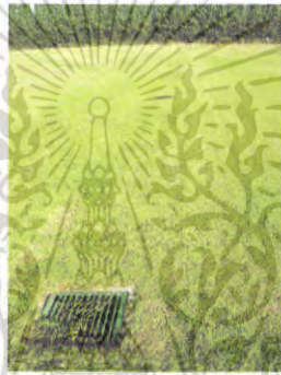
ภาพ 6-2 รูปบ่อพักน้ำจากการระบาย และใช้สูบลกลับมารดน้ำสนามได้
