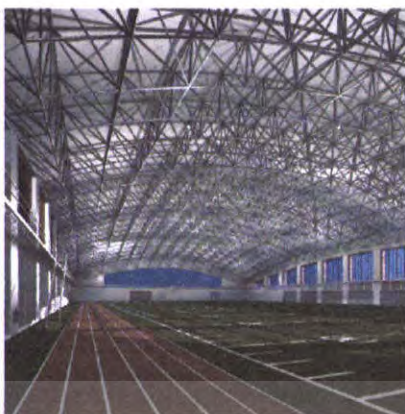
ภาพ6-8 แสดงสนามกีฬาที่ใช้โครงสร้าง SPACE TRUSS
