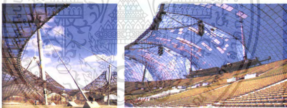
ภาพ6-20 แสดง OLIMPIC STADIUM, GERMANY ใช้โครงสร้างโครงขึงต่ำชาย
