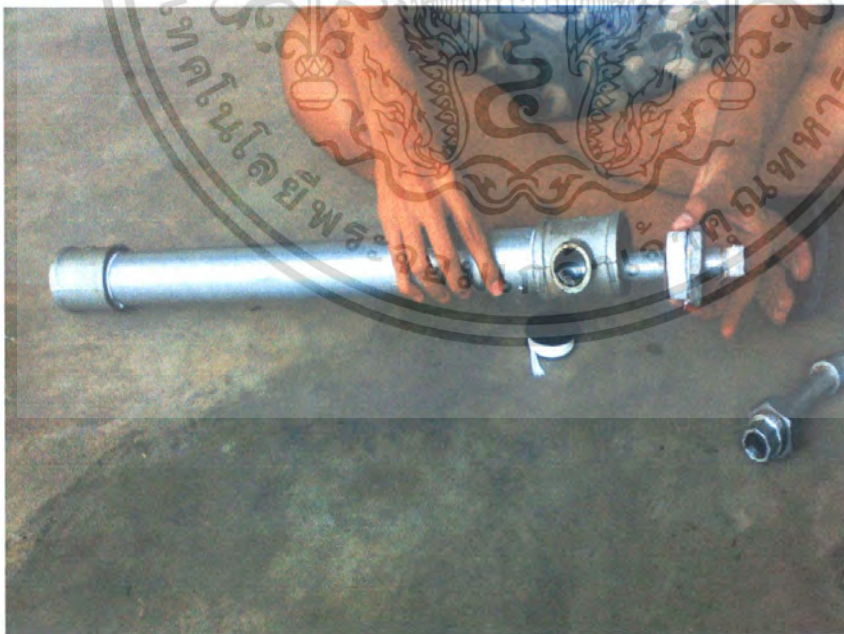
รูปที่ 3.4 สอดท่อ 0.5 นิ้ว ไว้ภายในท่อ 1.5 นิ้ว แล้วจึงนำข้อลดเหลี่ยมมาต่อกับท่อ 1.5 นิ้ว
