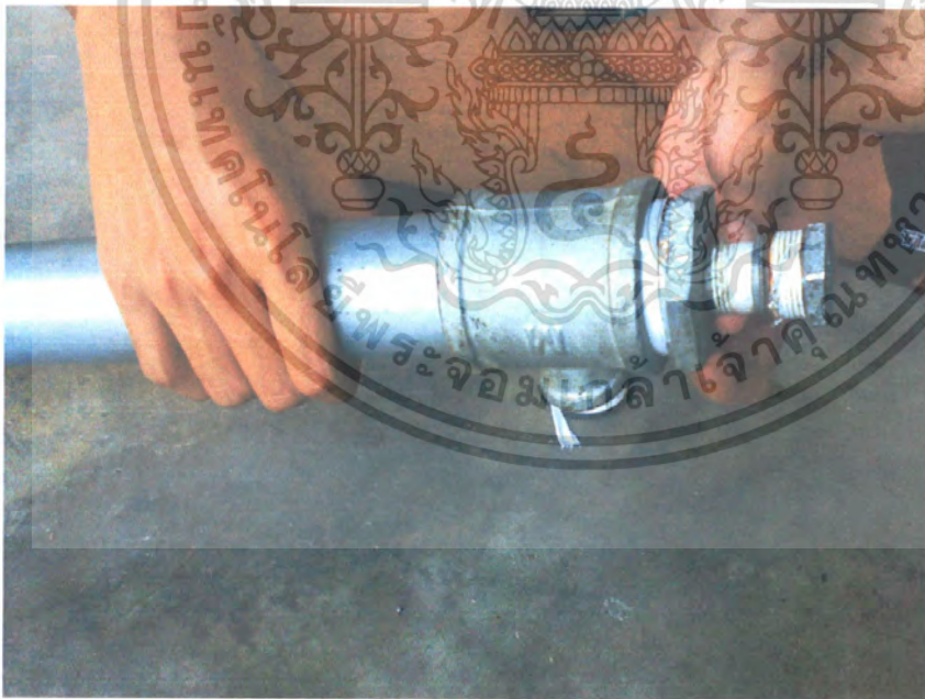
รูปที่ 3.6 นำข้อลดเหลี่ยม \frac{3}{4} - 0.5 นิ้ว มาต่อกับท่อ 0.5 นิ้ว
