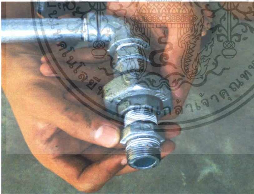
รูปที่ 3.12 นำ Nipple มาต่อกับเข้ากับ Union
