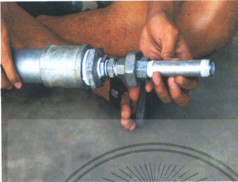
รูปที่ 3.9 นำ Union มาต่อระหว่าง Nipple กับท่อ 0.5 นิ้ว
