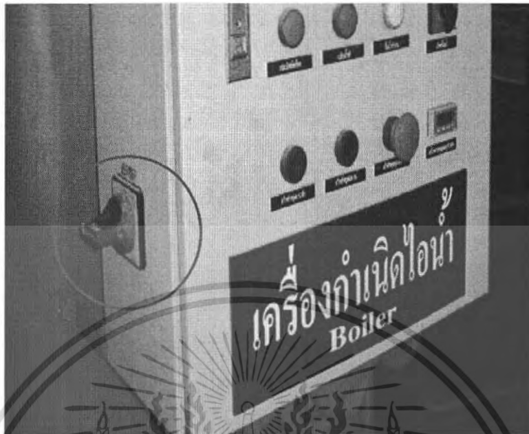
รูปที่ ค.6 ตำแหน่งของสวิตช์เปิด-ปิด เครื่องกำเนิดไอน้ำ
