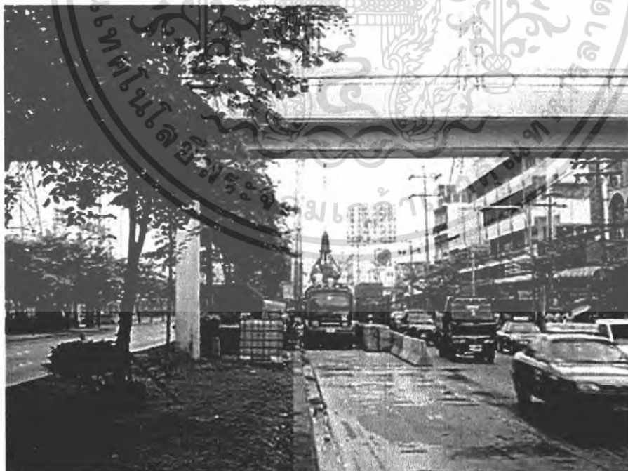
รูปภาพที่ 6.19 ดินที่ขุดแล้วจะถูกลำเลียงออกไปโดยรถบรรทุก
