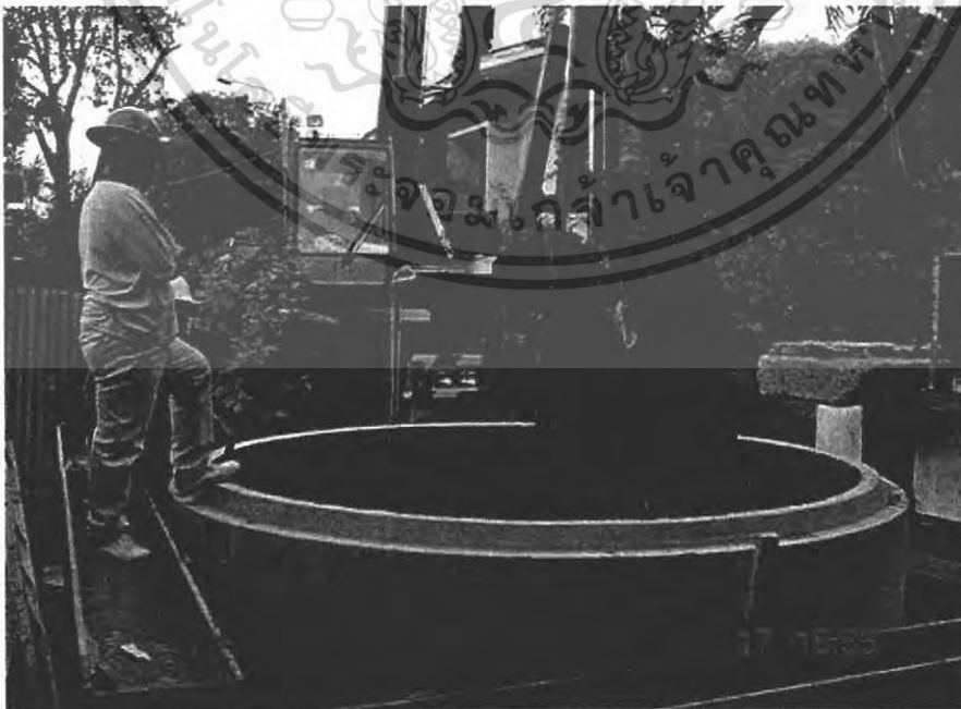
รูปภาพที่ 6. 13 แสดงการขุดดินออกจากบ่อ
