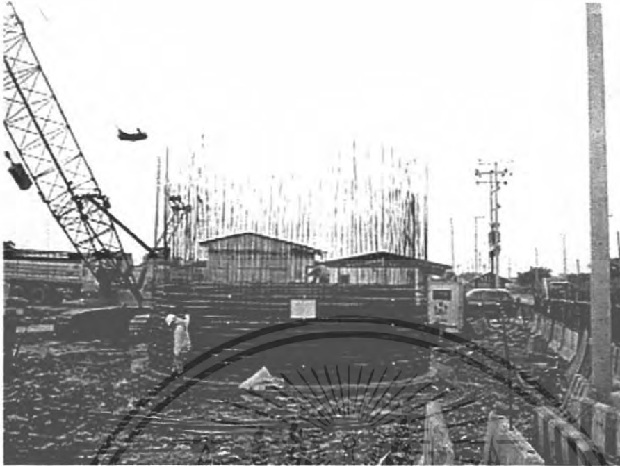
รูปภาพที่ 6.16 แสดงโครงเหล็กของบ่อแบบหล่ออยู่กับที่
