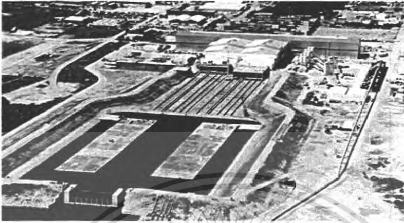
รูปภาพที่ 7.6 แสดงบริเวณสถานที่ทำการก่อสร้างตัวอุโมงค์
