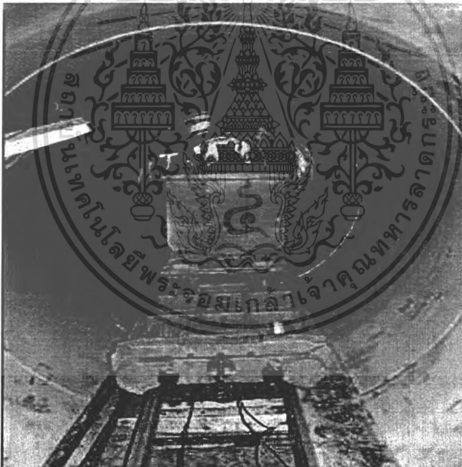
รูปภาพที่ 3.10 แสดงการขนย้ายดินแบบล้อเลื่อน
