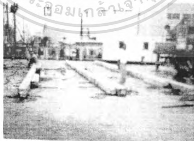
ภาพประกอบที่ 2.2-15 แสดงรูปภาพการปรับระดับพื้นที่หน้างาน และการวางฐานรองรับตู้คอนเทนเนอร์
