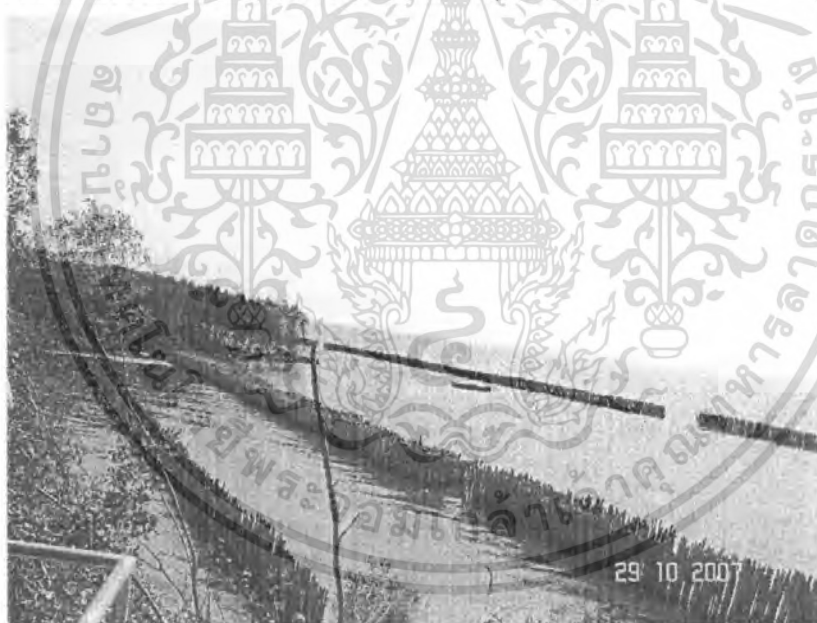
ภาพที่ 3 แนวสลายพลังงานคลื่นแบบแนวไม้ไผ่
