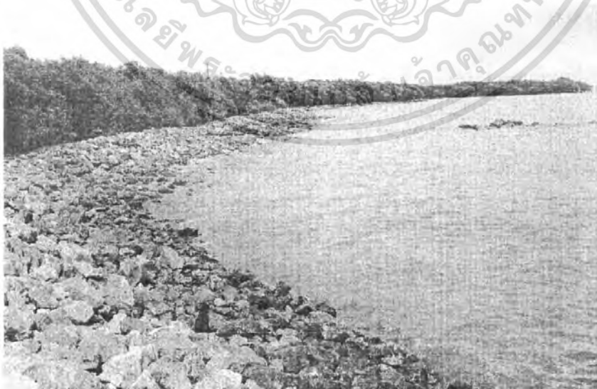
ภาพที่ 5 แนวสลายพลังงานคลื่นแบบแนวหินทิ้ง
