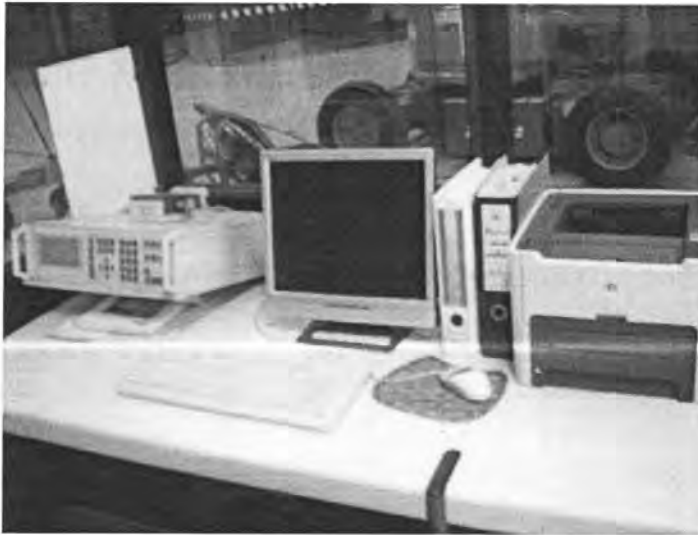
รูปที่ 3.12 ชุดควบคุมและแสดงผลการทดสอบความคงทนของฉนวนต่อแรงดันอิมพัลส์
