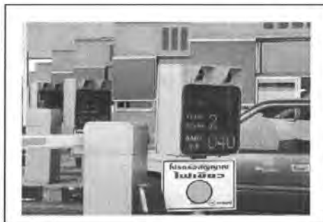
ภาพที่ 10 ตู้บอกราคาแสดงค่าผ่านทางตามระยะทาง
