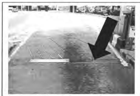
ภาพที่ 15 Axle Detector
