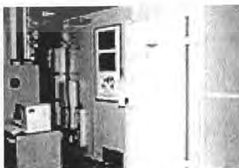
รูป ข. Conducted Emission Room ที่ PTEC
