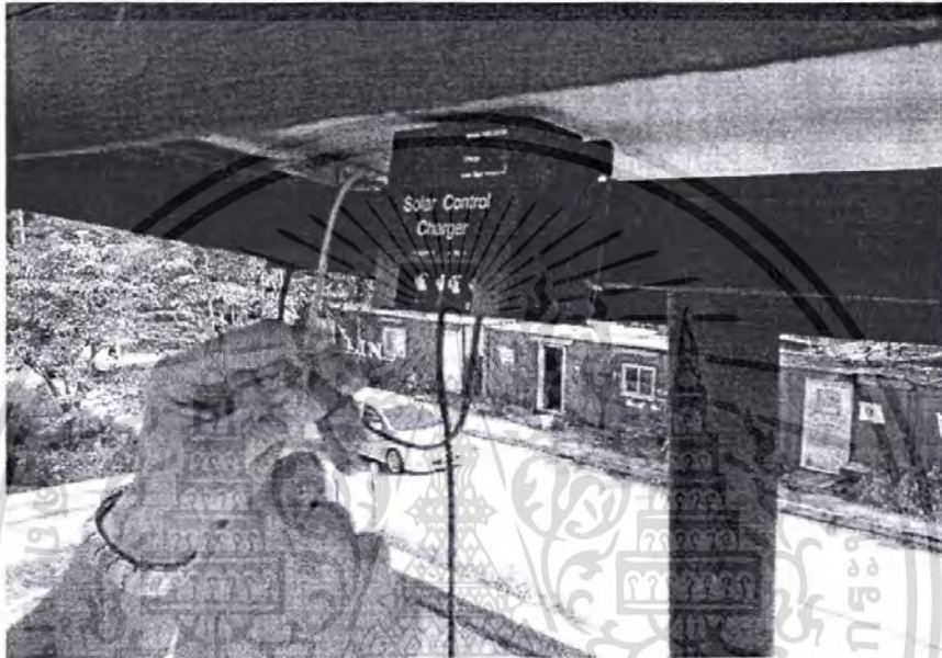
รูปที่ 3.2. แสดงการติดตั้งเครื่องควบคุมการประจุเข้ากับแผงเซลล์แสงอาทิตย์
