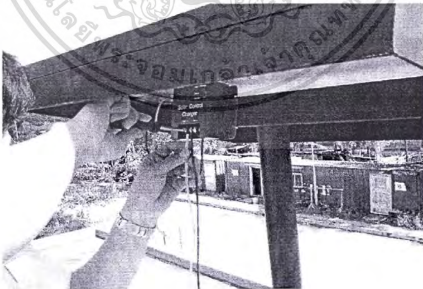
รูปที่ 3.3. แสดงการต่อสายไฟจากเครื่องควบคุมการประจุ
