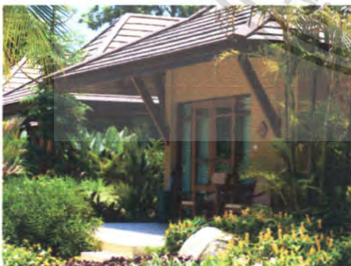
ภาพที่ 2.133 แสดงบรรยากาศและ โครงสร้างอาคารของส่วน GARDEN VILLA , BEACH FRONT VILLA
