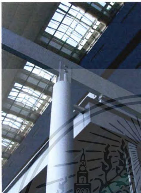
ภาพ 3-34 ส่วนของข้อต่อเสาและคานเหล็ก
