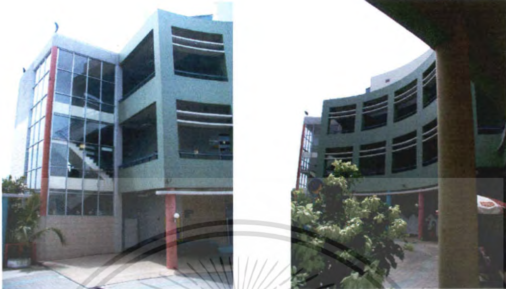
ภาพ 3-16-17 แสดงลักษณะและรูปแบบอาคารเพื่อการสร้างสรรคจินตนาการ ของเด็ก
