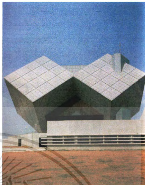
ภาพ 3-7 ด้านหลังอาคาร
