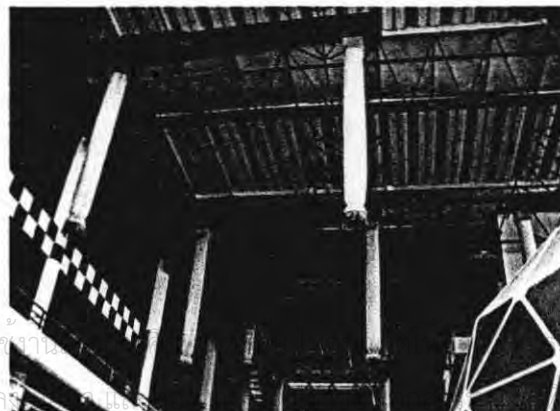
ภาพที่ 1.4 ปัญหาระบบปรับอากาศ
