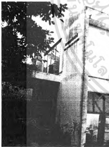
อาคารบำรุงรักษาฟิล์มภาพยนตร์
