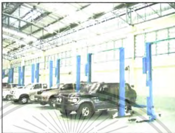
ภาพที่ 2.17 ตัวอย่างหลังคาแบบมีหลังยกยกระดับ เพื่อการระบายอากาศ
